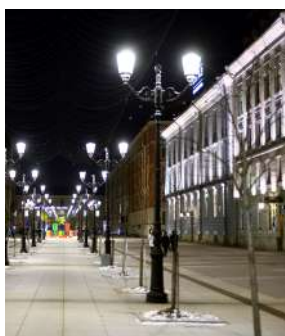
Уличное освещение и архитектурная подсветка зданий
