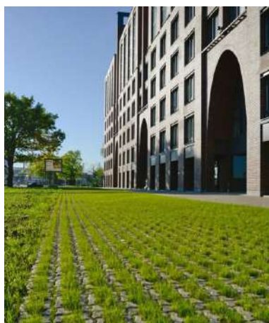
Проницаемое покрытие, «ЖК Четыре горизонта» в Санкт-Петербурге
