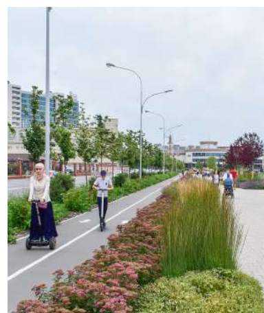
Система отвода воды — дождевые сады, набережная озера Кабан в Казани
